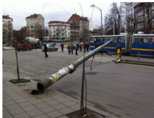
Фиг. 2 Паднал стълб на градски транспорт в гр. София, вследствие на корозия в основата му
